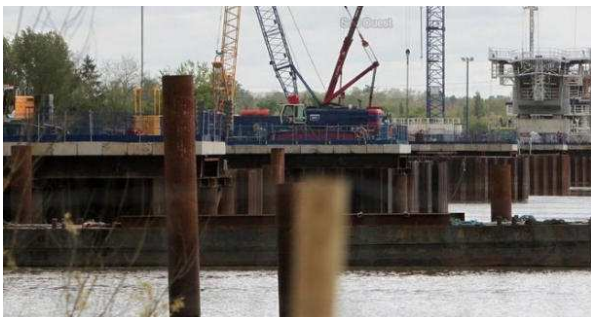
Photographie 4 : Exemple d'estacade - chantier LGV Bordeaux
